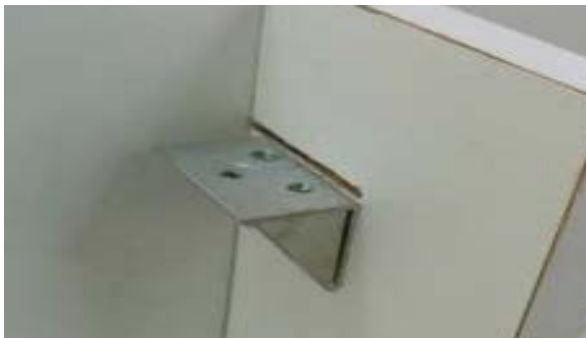
Figura 4 – Detalhe dos parafusos de fixação.
